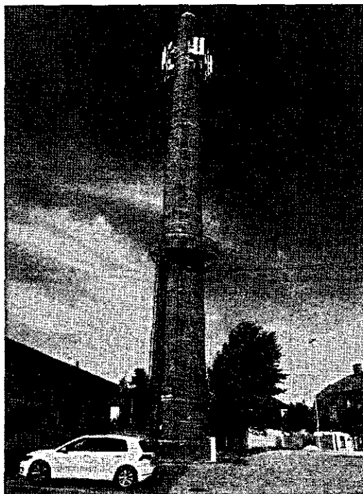
Zał. nr 1: Widok ogólny instalacji radiokomunikacyjnej.
