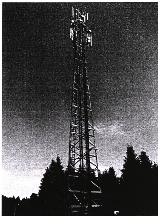
Zał. nr 1: Widok ogólny instalacji radiokomunikacyjnej.
