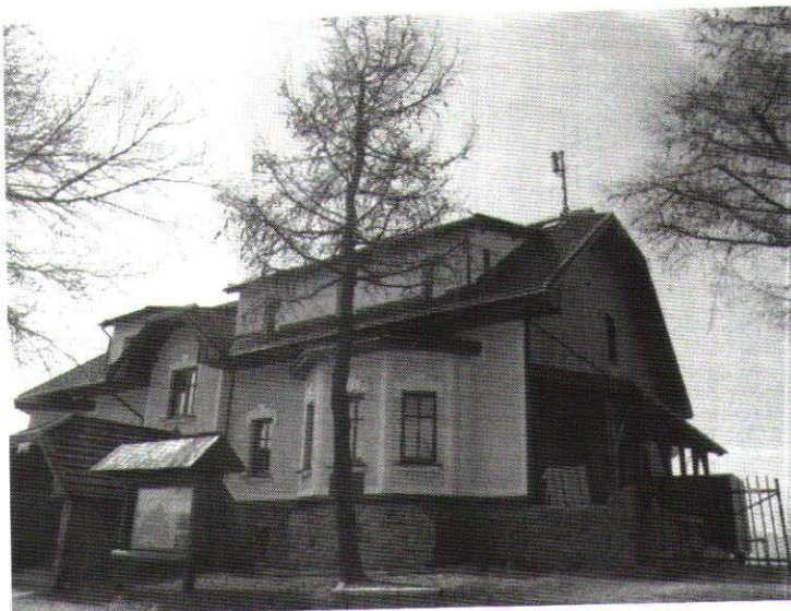
Zat. nr 1: Widok ogólny instalacji radiokomunikacyjnej.
