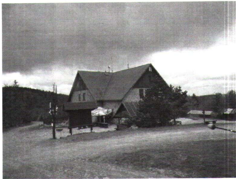
Zat. nr 1: Widok ogólny instalacji radiokomunikacyjnej.
