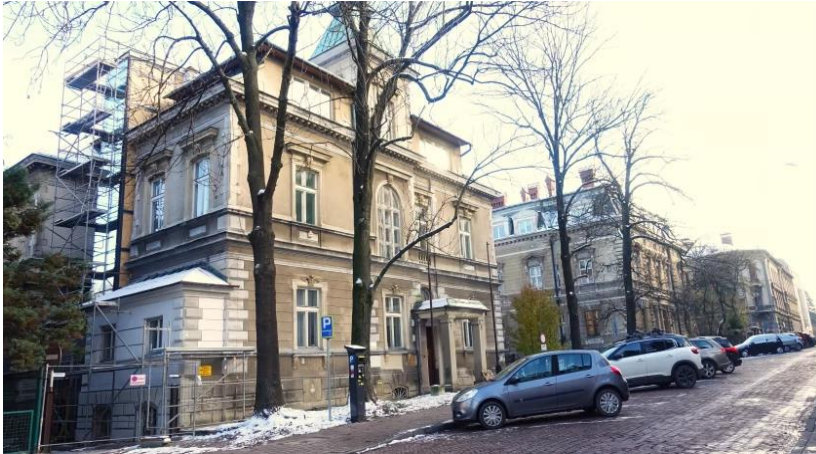
Rysunek 6 - Remont budynku przy ul. Krasieńskiego 28
