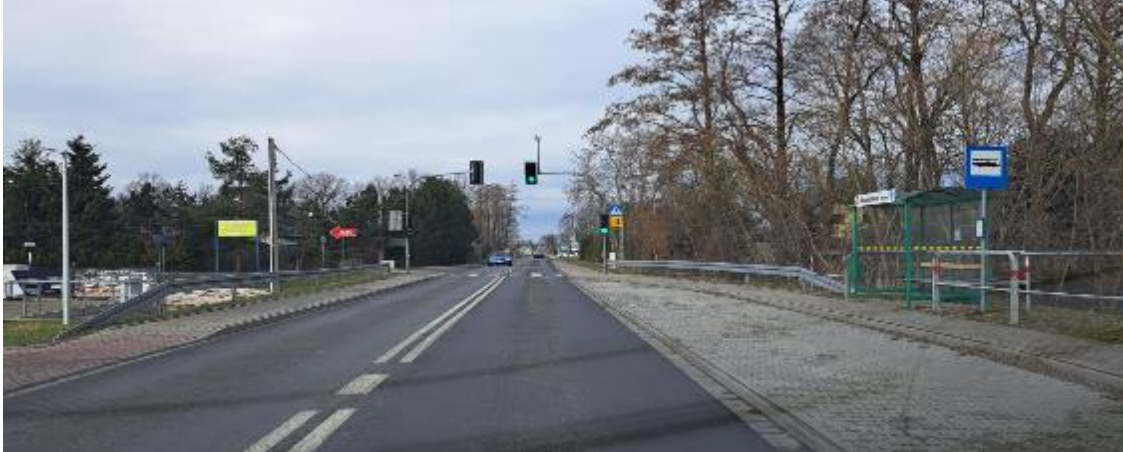
Rysunek 29 - Zdjęcie w ciągu drogi powiatowej 4427S w Mazańcowicach (po inwestycji)
