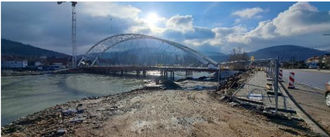
Rysunek 22 - Zdjęcie mostu na rzece Soła w Porąbce (w trakcie realizacji)
