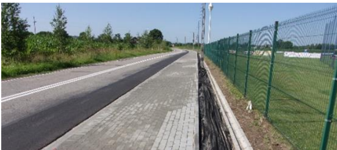
Rysunek 25 - Zdjęcie w ciągu drogi powiatowej 2638S w Landeku (po inwestycji)
