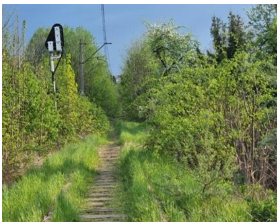
Rysunek 50 - Linia kolejowa 190 - stan obecny
