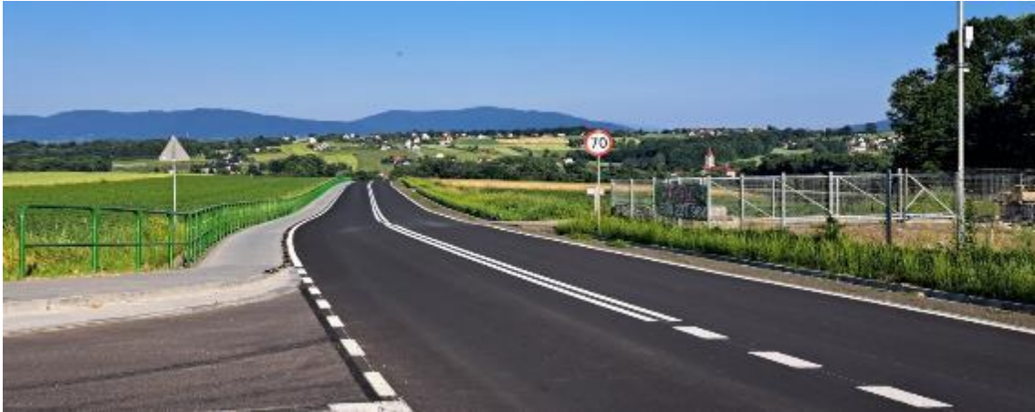
Rysunek 18 - Zdjęcie w ciągu drogi powiatowej 4424S w Rudzicy (po inwestycji)
