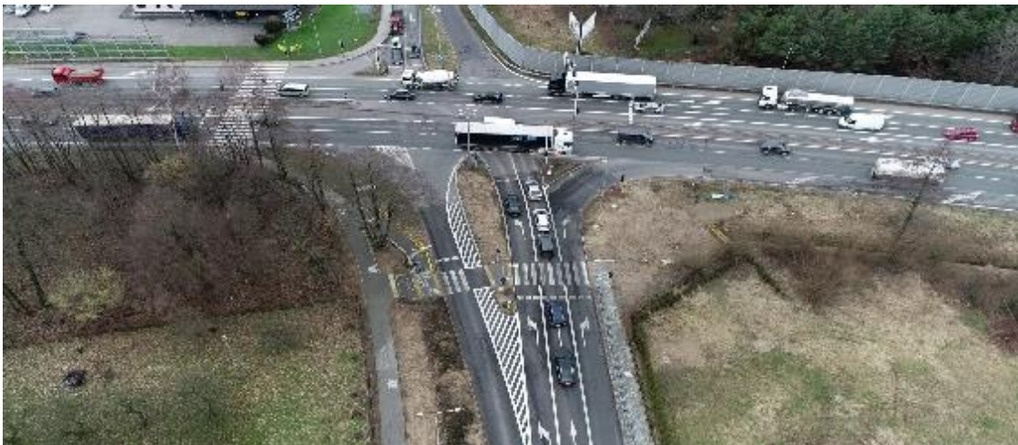
Rysunek 24 - Zdjęcie w ciągu drogi powiatowej 4116S w Czechowicach-Dziedzicach (po inwestycji)
