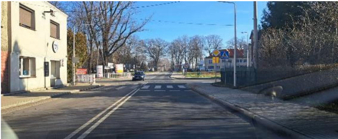
Rysunek 19 - Zdjęcie w ciągu drogi powiatowej 4441S w Czechowicach-Dziedzicach (po inwestycji)
