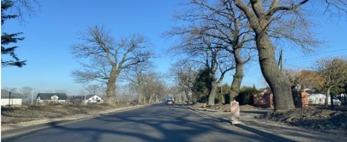
Rysunek 20 - Zdjęcie w ciągu drogi powiatowej 4444S w Dankowicach (w trakcie realizacji)
