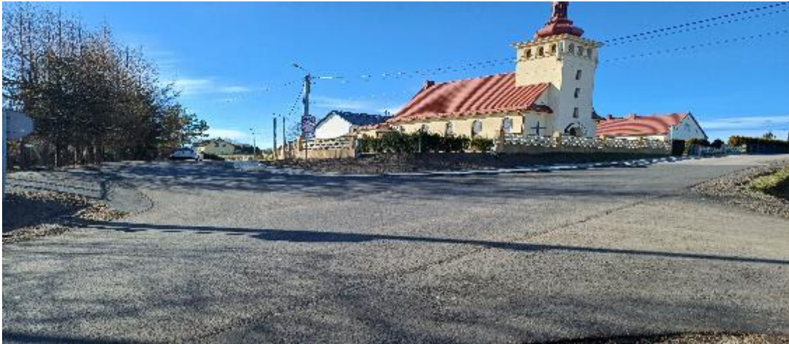
Rysunek 27 - Zdjęcie w ciągu drogi powiatowej 4419S w Łazach (po inwestycji)
