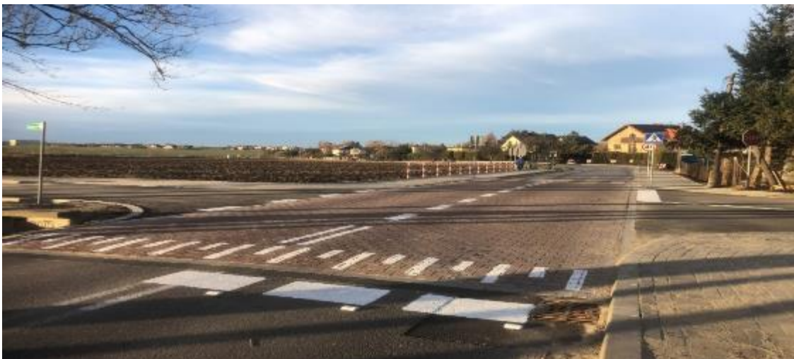
Rysunek 28 - Zdjęcie w ciągu drogi powiatowej 4413S w Jaworzu (po inwestycji)
