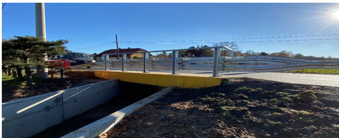
Rysunek 22 -przepust w ciągu drogi powiatowej nr 4466S ul. Młyńskiej w Kaniowie (po realizacji inwestycji)
