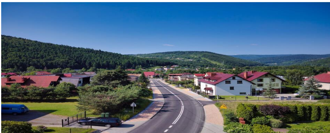
Rysunek 14 - droga powiatowa nr 4477S ul. Bukowska w Porąbce (po realizacji inwestycji)
