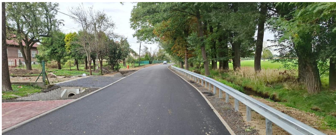
Rysunek 17 - droga powiatowa nr 4431S ul. Rolników w Ligocie (po realizacji inwestycji)
