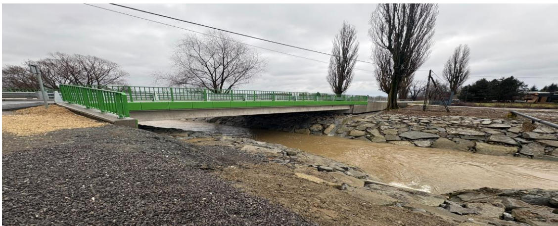
Rysunek 20 - most w ciągu drogi powiatowej nr 4425S ul. Zabrzeskiej w Ligocie (po realizacji inwestycji)
