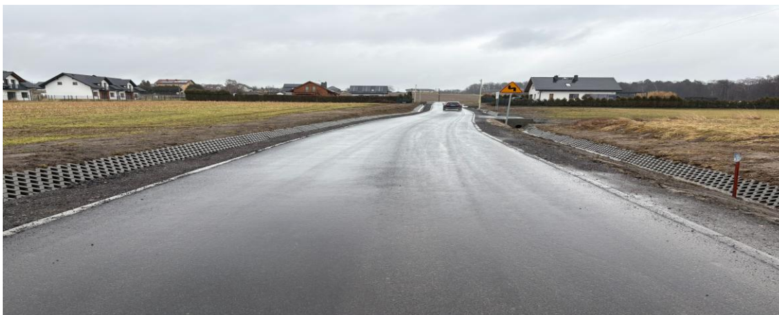
Rysunek 18 - droga powiatowa nr 4440S ul. Mazańcowicka w Czechowicach-Dziedzicach (po realizacji inwestycji)
