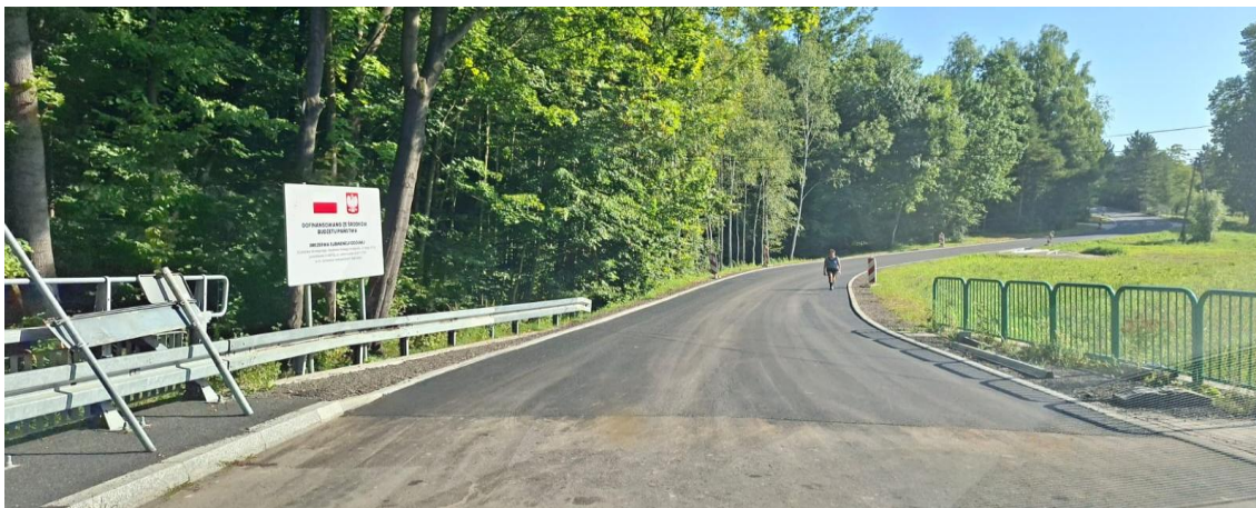
Rysunek 13 - droga powiatowa nr 4470S ul. J. Kubika w Janowicach (po realizacji inwestycji)
