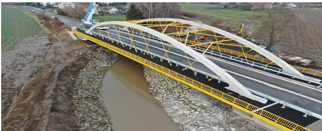
Rysunek 21 - most w ciągu drogi powiatowej nr 4426S ul. Bielskiej w Ligocie (po realizacji inwestycji)
