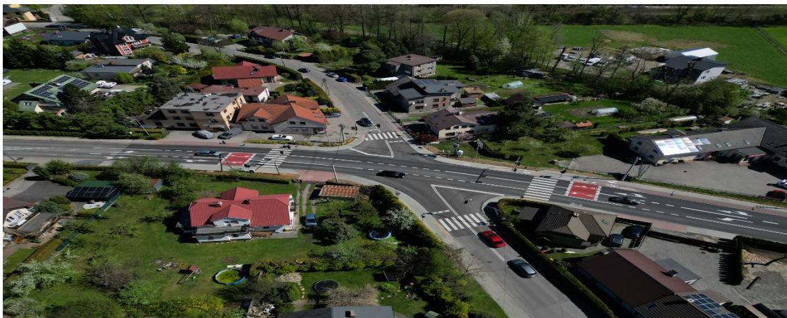
Rysunek 12 - droga powiatowa nr 4116S ul. Legionów w Czechowicach-Dziedzicach (po realizacji inwestycji)
