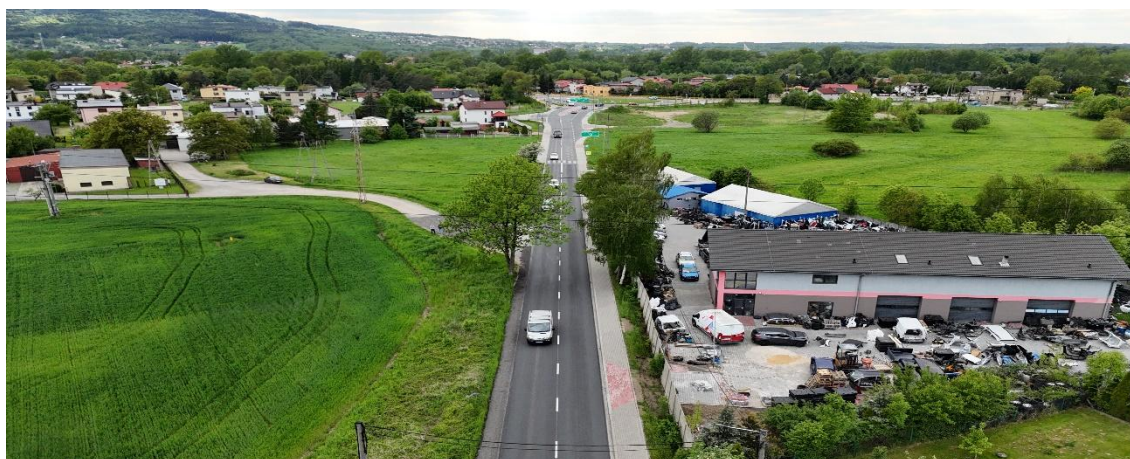
Rysunek 16 - droga powiatowa nr 4479S ul. Kardynała Karola Wojtyły w Czańcu (po realizacji inwestycji)
