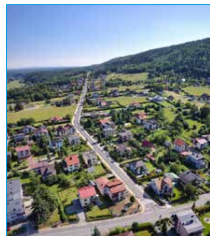
Wyremontowana droga w gminie Porąbka
